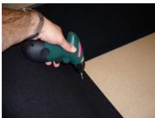
Fig. 4. Skumsiderne skrues nu fast i bundpladerne og beskyttelsestape monteres over skruehovederne.
